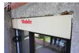
Raffstore-Unterputzkasten im Zuge einer Fenstersanierung
