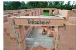
Versetzen vom Ziegel-Rollladenkasten beim Neubau
